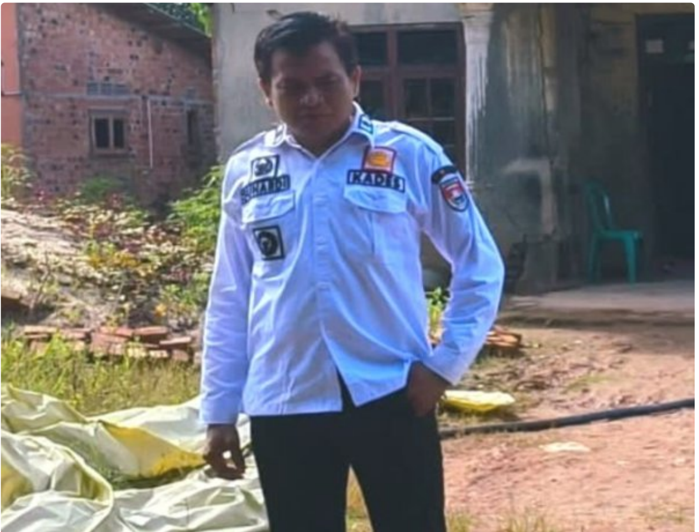
Kades Mekarsari Sunardi Mantau Pembangunan Jalan Rabat Beton
